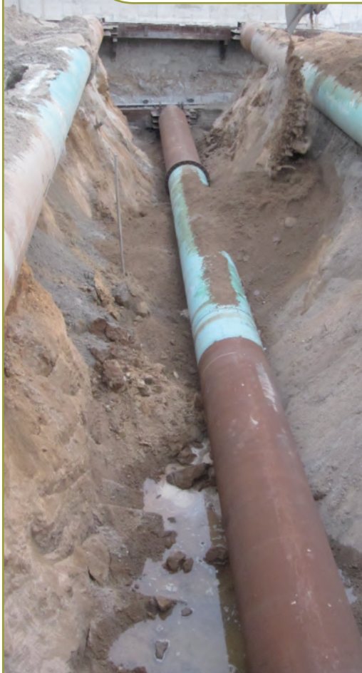
Foto 2 - benodigd grondverzet voor aanbrengen stempelbuizen
