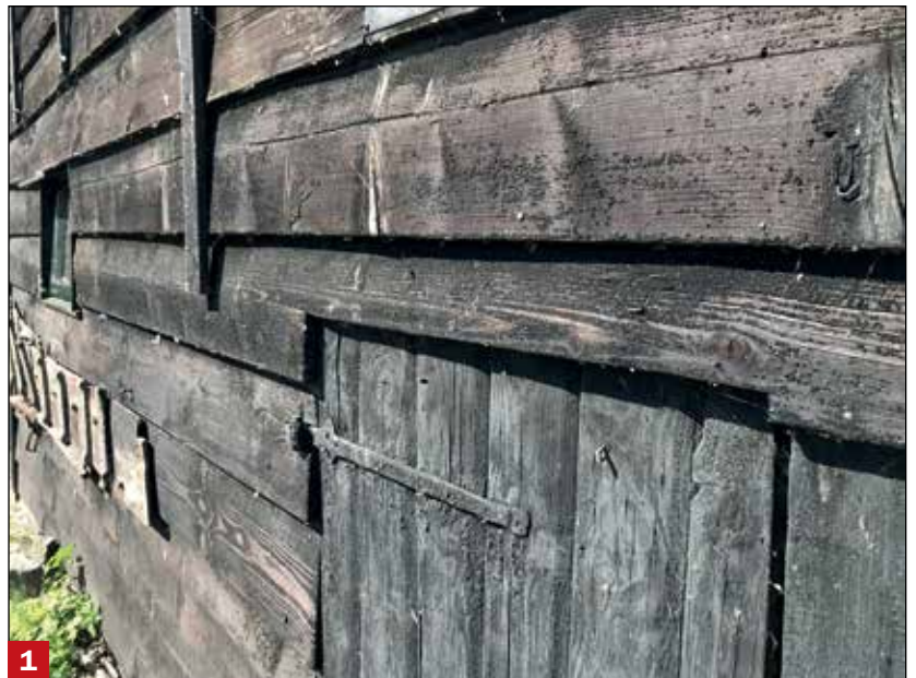
1 Een zwart geteerde schuur ter bescherming van de houtconstructie (bron: Ad van der Aa)
