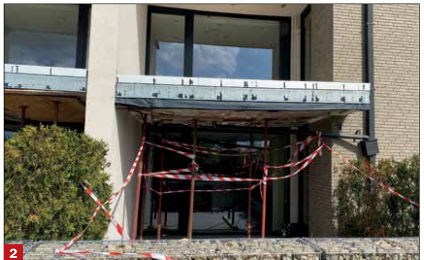
2 Schade aan een appartementencomplex in Sint-Truiden, veroorzaakt door schimmels (bron: Jozef Croughs)
