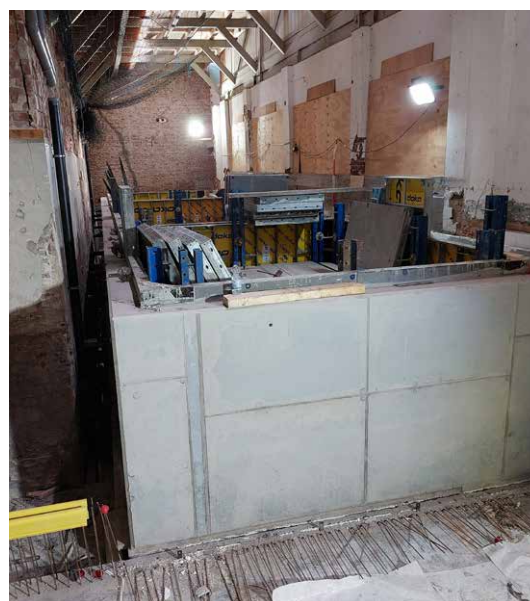
Ontkiste wand 2 (zelfhelend beton)
