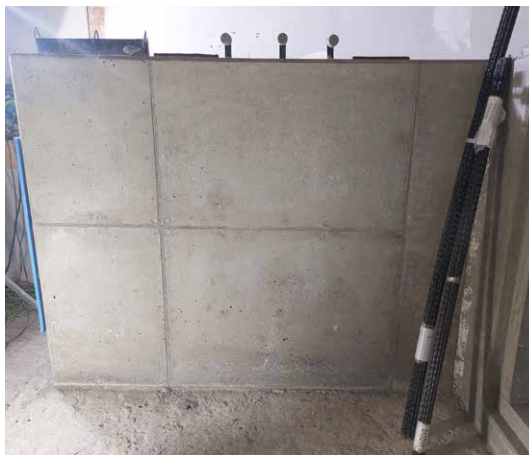
Mock-up 1; testwand aquarium inclusief sponning voor het glas
