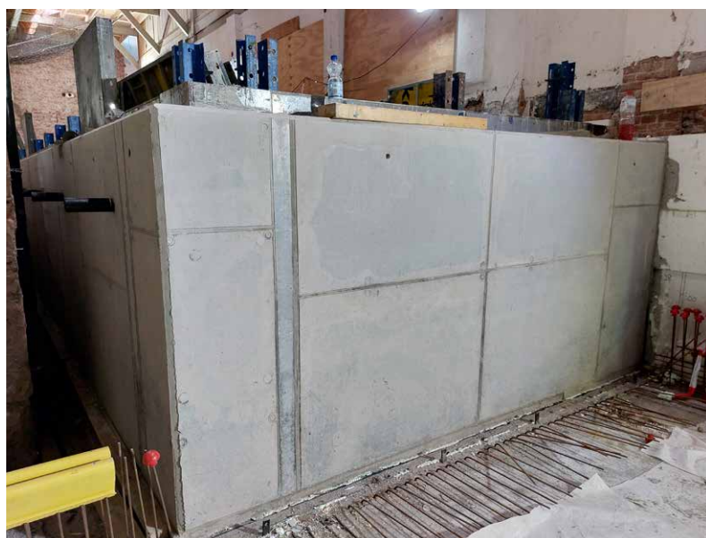
Ontkiste wand 1 (zelfhelend beton)
