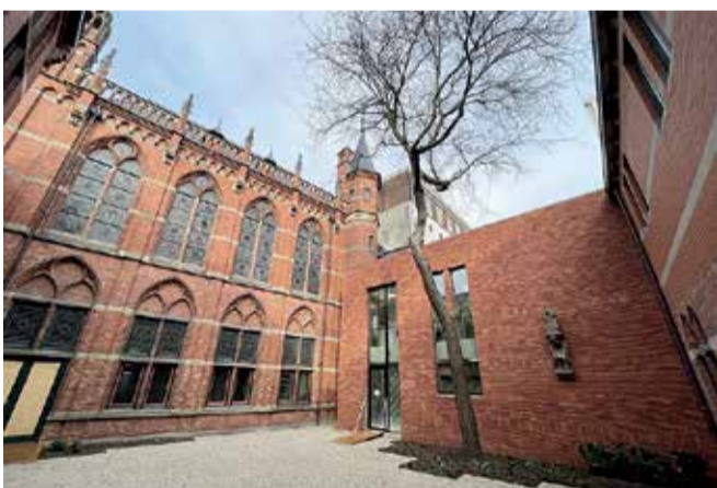
In de binnenplaats is ruimte gevonden voor een klein stukje nieuwbouw: de twee verdiepingen tellende keuken voor het grand-café. Een van de ornamenten, die aan de originele gevel hing, is nu aan de nieuwe gevel opgehangen.
