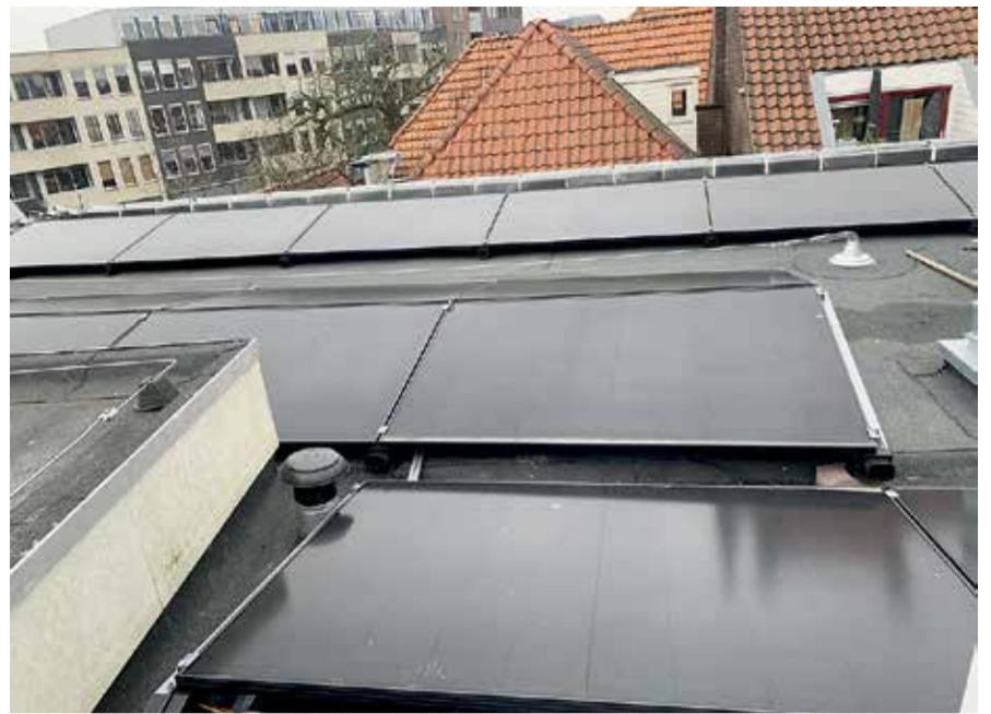
Ook de zonnepanelen zijn relatief vlak geplaatst. In totaal zijn op drie dakdelen van het Statenzaalgebouw 55 pv-panelen geïnstalleerd.
