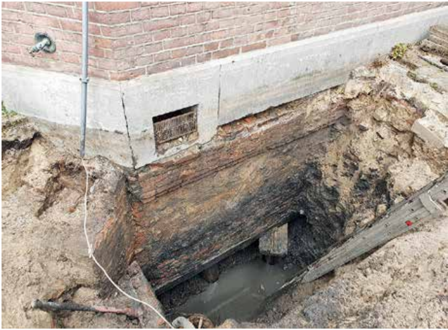
De houten funderingspalen zijn blootgelegd, en bleken nog van goede kwaliteit.
