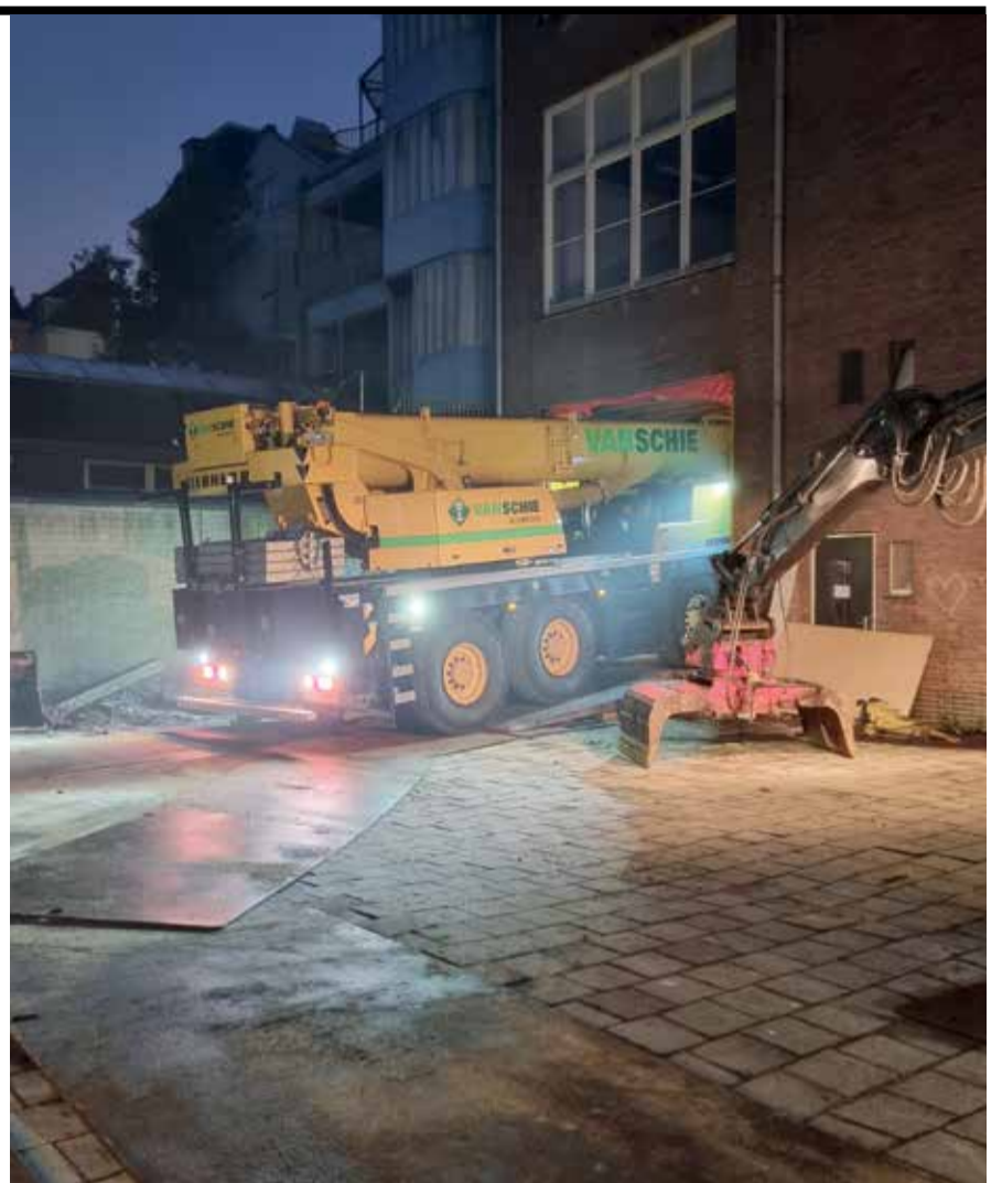
Voor de uitvoering van de WKO in de achtertuin van de voormalige kweekschool was een loodzware mobiele kraan nodig. Om die achter het pand te krijgen is een opening in het bestaande pand gemaakt, waardoor de kraanwagen naar achteren kon rijden.
