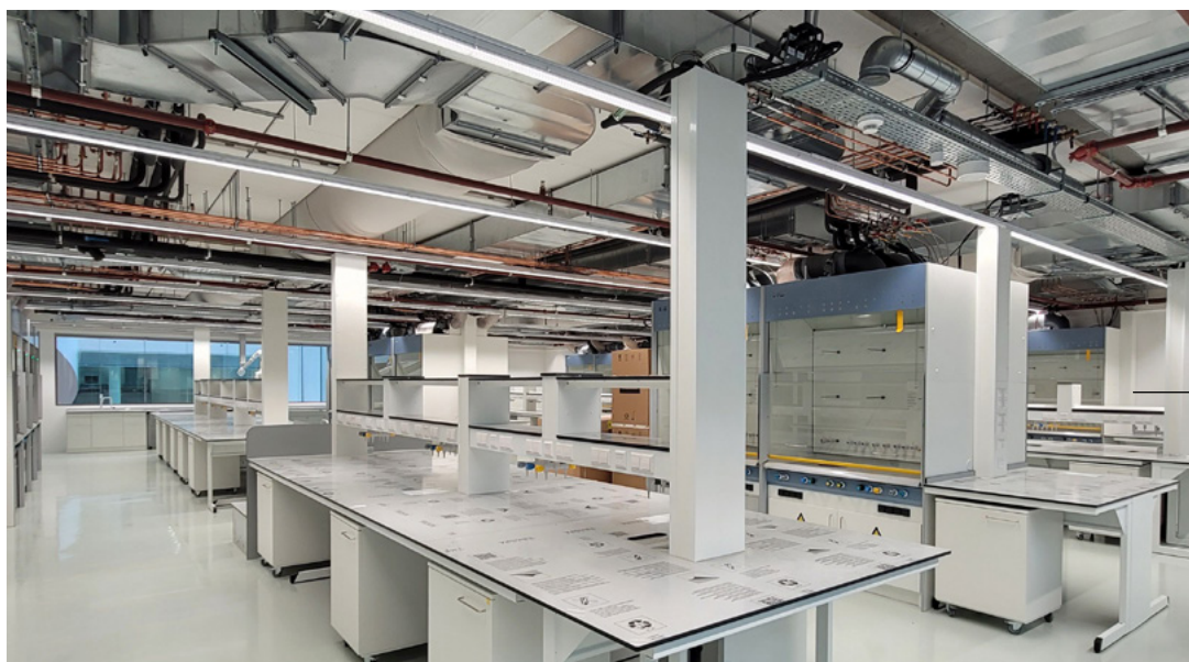
Foto 2: Het ventilatiesysteem in het Gorlaeus Gebouw is bijzonder. Het is een lagedruk ventilatiesysteem met een ringvormig kanalenstelsel in het hele gebouw.
