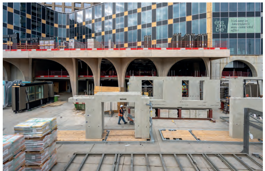
Onder: een deel van de betonluifel van het plintgebouw, met weinig opstelruimte voor de prefab casco-elementen (foto: Roos Aldershoff Fotografie).
