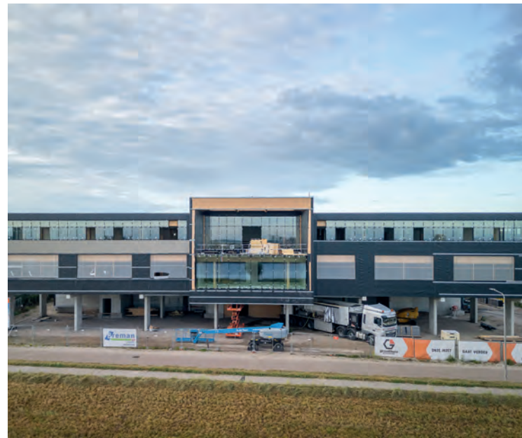
In het pand van Breman Installatiegroep is driekwart van de kanaalplaatvloer demontabel uitgevoerd.
